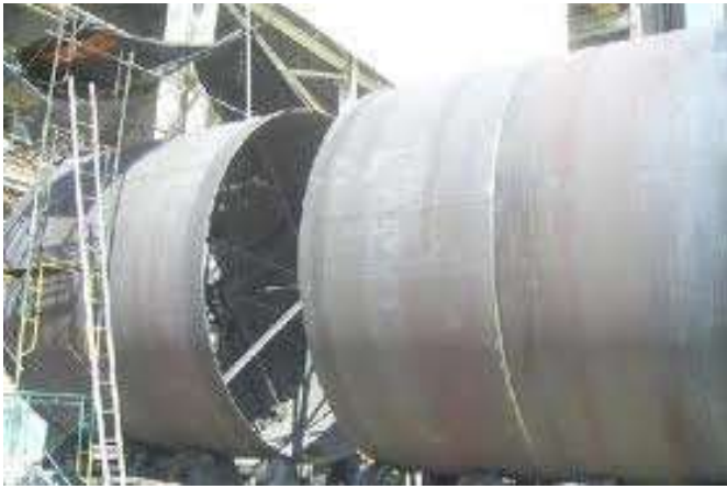
Gambar 4. Proses fit-up yang sudah di roll
