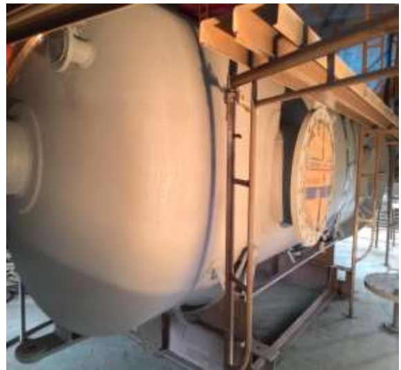
Gambar 11. Bagian permukaan vessel setelah di proses menggunakan cat primer
